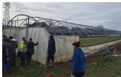
Le tunnel avant le chantier
