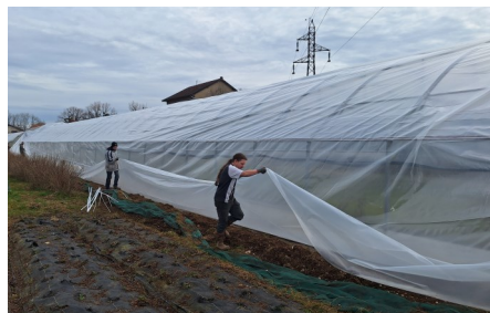
La bâche est installée, il reste encore à fixer la bâche dans le sol
