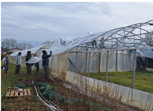
La mise en place de la bâche
