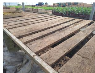
Les tables après rénovation
