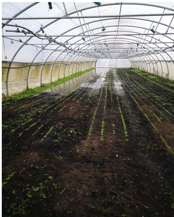
Tunnel de carottes
