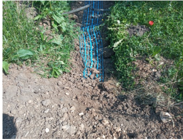
Grillage avertisseur dans une tranchée
