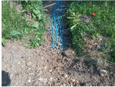
Grillage avertisseur dans une tranchée
